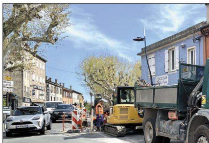
Les travaux sur les réseaux d'eau potable et d'assainissement ont débuté à Pégomas. Ils doivent s'étaler sur quatre mois. (Photo A. C.)
